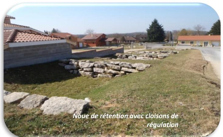
*Noue de rétention avec cloisons de régulation*
