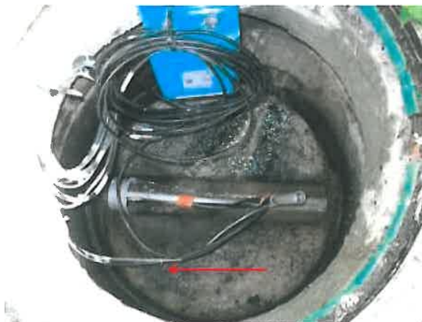
Organe déprimogène et débitmètre
