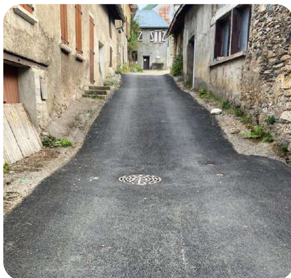
Voirie rue de la Lignarre au Rivier d'Ornon.
