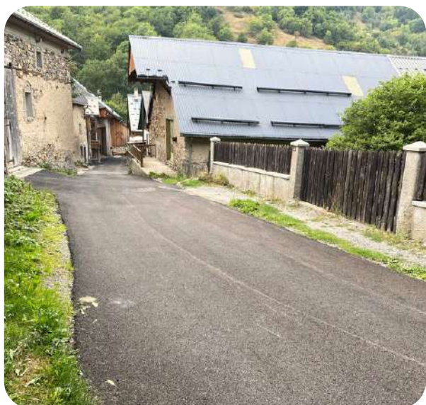
Voirie rue du Colportage au Rivier d'Ornon.
