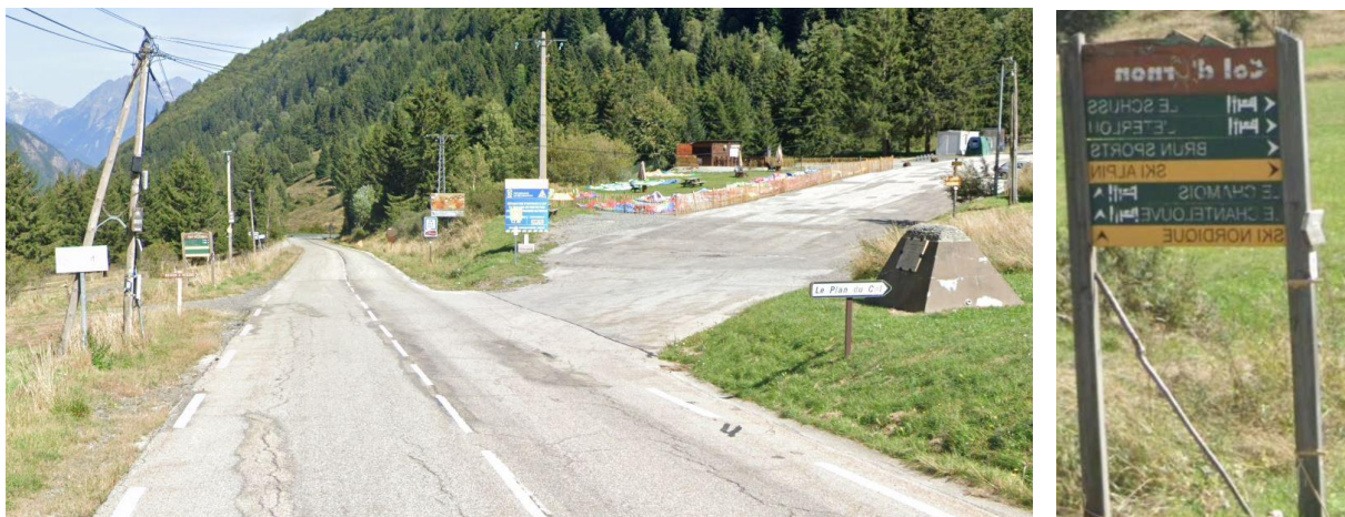
Intersection entre la route communale et la route D526 (à gauche) et son panneau d'indication touristique (à droite)
