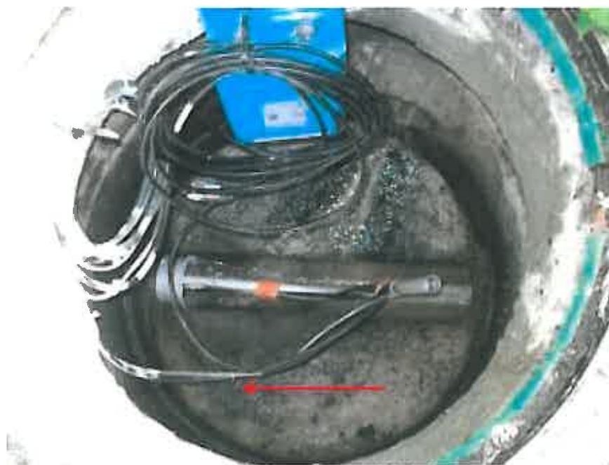
Organe déprimogène et débitmètre
