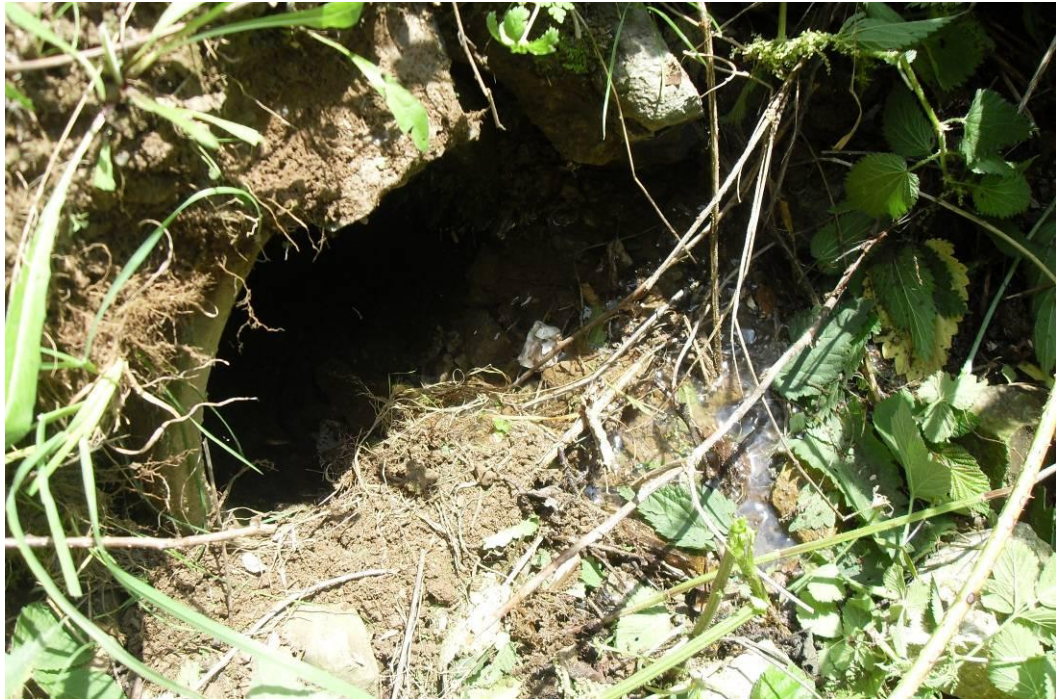
Le Guillard : Exutoire du rejet
