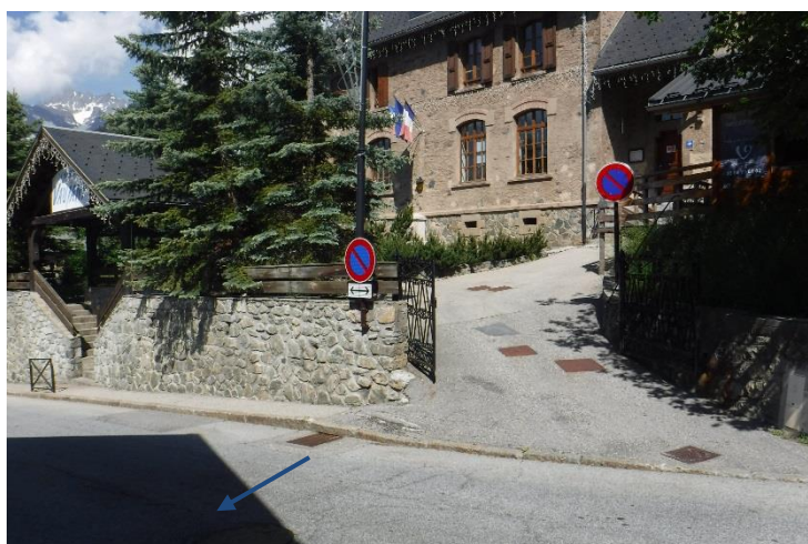
Débordement de la grille sur la voirie – Commune de Vaujany
