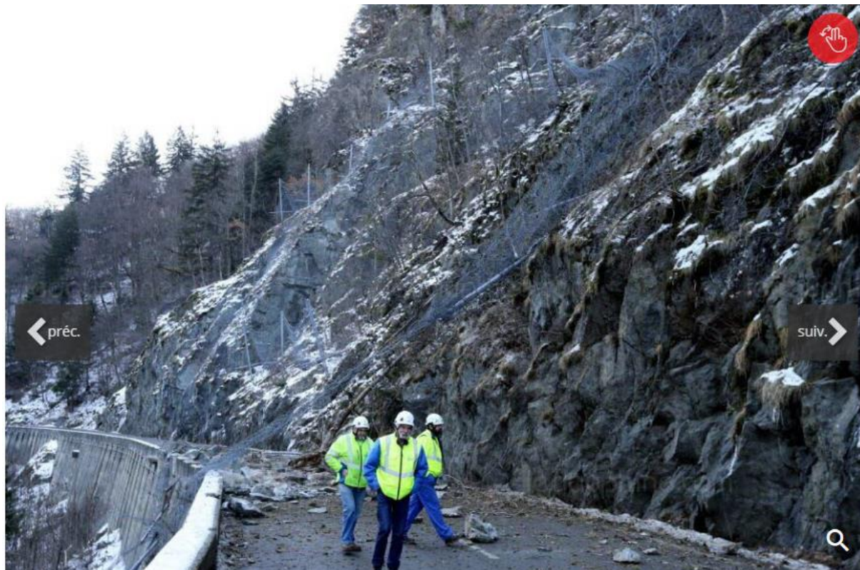
Glissement de terrain sur la RD1091 au Freney-d'Oisans Source : Le Dauphiné - Photographe : Christophe AGOSTINIS – 20/01/2016
